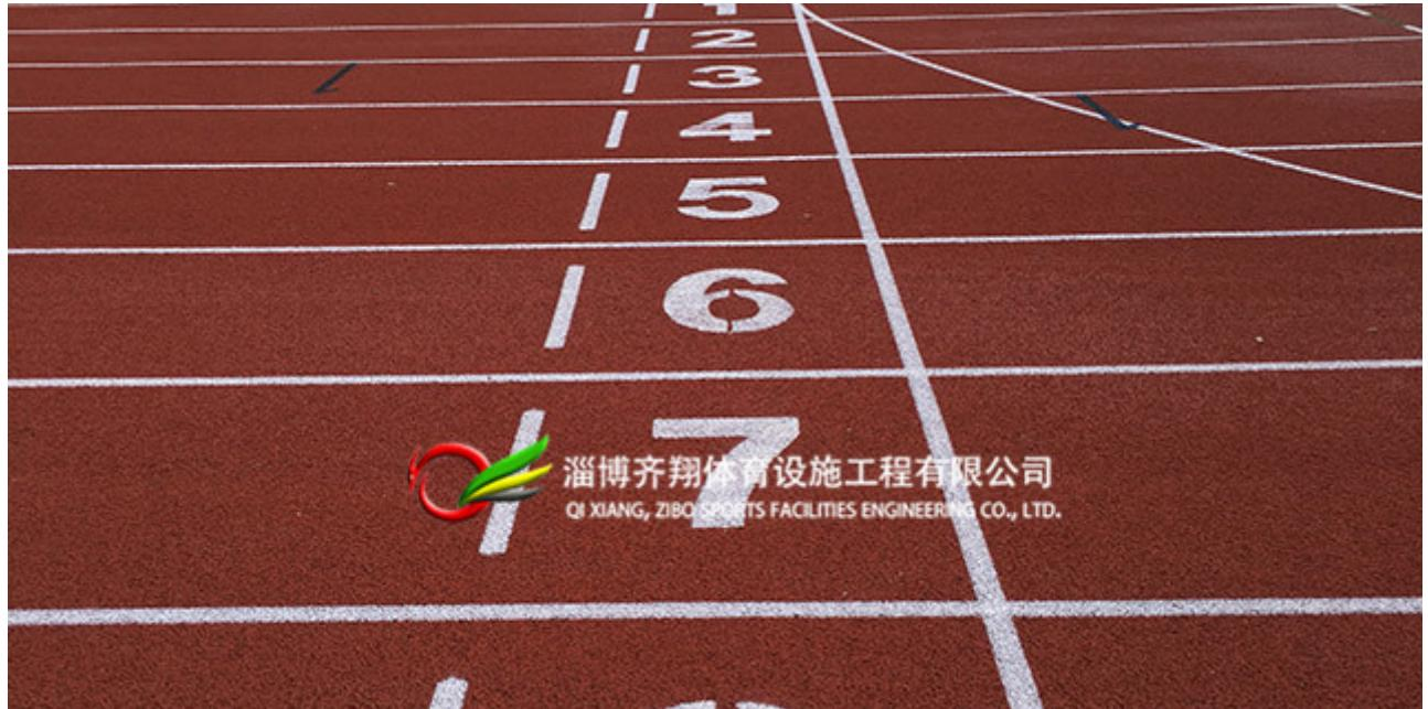
全塑型塑胶跑道产品特点：主要材料是双组份聚氨酯，基础层为天然橡胶及人工橡胶，混合矿物质填充剂、稳定剂及色料在280–300℃的高温加硫硬化一体成型。结合运动科学和材质科学，能充分满足和体现运动员参与者对跑道的专业要求。无溶剂塑胶跑道无溶剂塑胶跑道工艺说明：无溶剂塑胶跑道是由的运动面层材料做成的环保型塑胶跑道，属于二苯甲烷二异氰酸酯[MDI]体系[MDI]合成面层材料无溶剂、无臭味、无污染的水性聚氨酯跑道材料。它是淘汰的TDI体系聚氨酯跑道材料的环保型运动铺装材料，性能先进、高科技含量、安全、可再生、适合各种条件下使用，对人体危害较小。其具体特点如下：1：不含TDI[不含苯、甲苯、二甲苯等挥发性溶剂，不含增塑剂，无重金属等有害添加物，无任何挥发性气味，对人体和环境友好，完全符合环保要求；2：施工便捷、粘接力强、铺设效率高、固化速度快、适应喷涂或机械摊铺等不同的施工要求，齐翔体育铺设过程无异味，不影响学校正常教学活动和周围居民正常生活；3：投入使用后无异味、无任何有害物质排放，减少对环境的污染。
